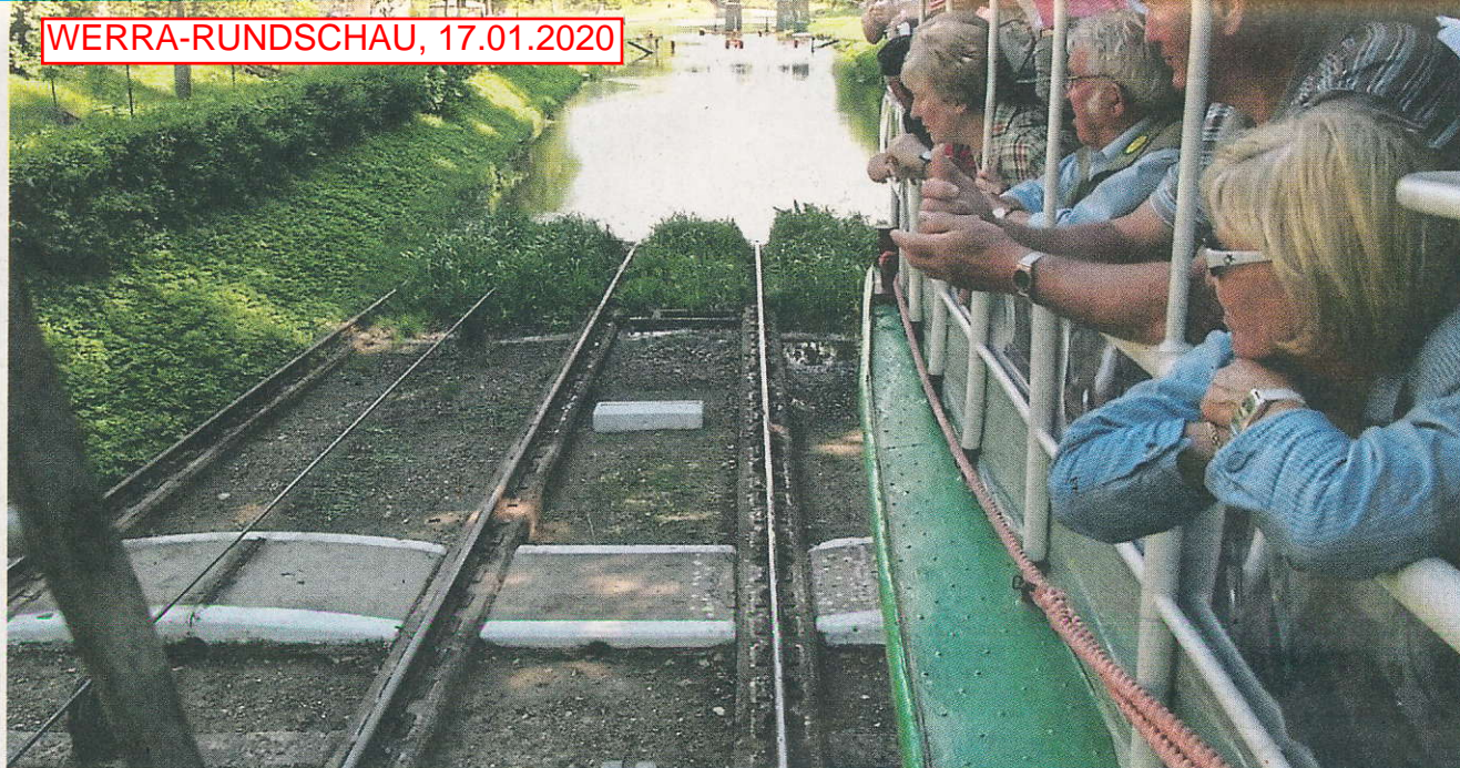
Langsamkeit ist Trumpf: Auf dem Oberlandkanal überwinden Schiffe auf fünf hügeligen Teilstrecken mithilfe von Rollwagen, auch „schiefe Ebenen“ genannt, durch Wasserkraft jeweils 21 Meter Höhenunterschied. FOTOS: KLAUS GOGLER/NH
